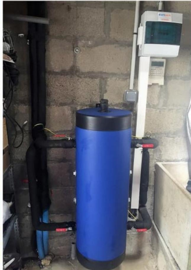
*Installation d'une pompe à chaleur air eau de marque Panasonic couplé a un ballon tampon d'une contenance de 50 litres. L'eau chaude sanitaire est assuré par un ballon d'eau chaude électrique.*
