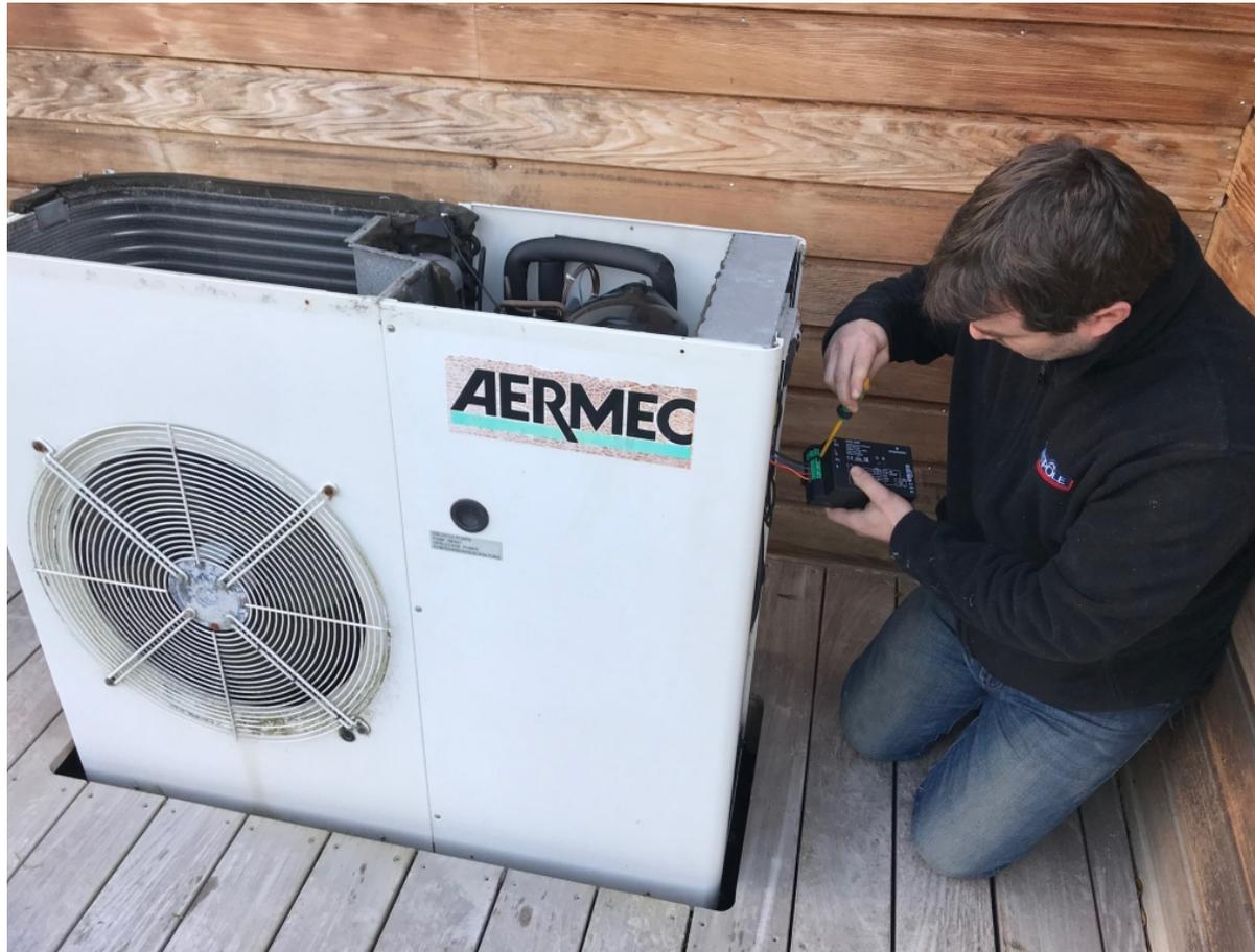
*Dépannage d'une pompe à chaleur de marque AERMEC. Après le diagnostic, j'ai réalisé le changement du démarreur de gestion du compresseur.*
