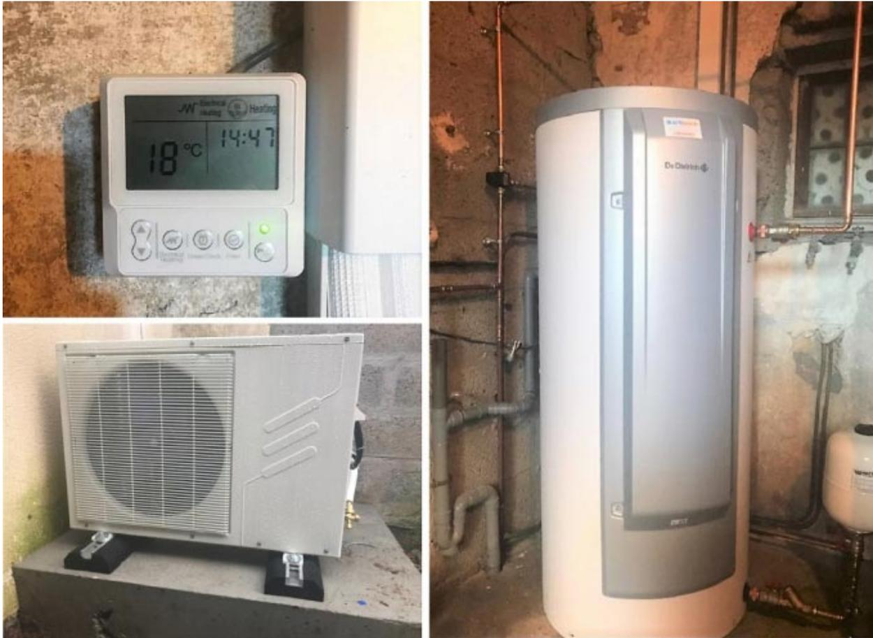
*Le modèle de chauffe-eau thermodynamique Kaliko SPLIT est composé d'une unité extérieure qui capte d'énergie dans l'air, et d'un ballon à installer à l'intérieur du logement ici un 200 litre .Grâce à ses liaisons frigorifiques , le chauffe-eau thermodynamique est simple à mettre en œuvre, il fonctionne toute l'année même à des températures de -15° à 42°C. il dispose également d'un COP parmi les plus élevé du marché.*
