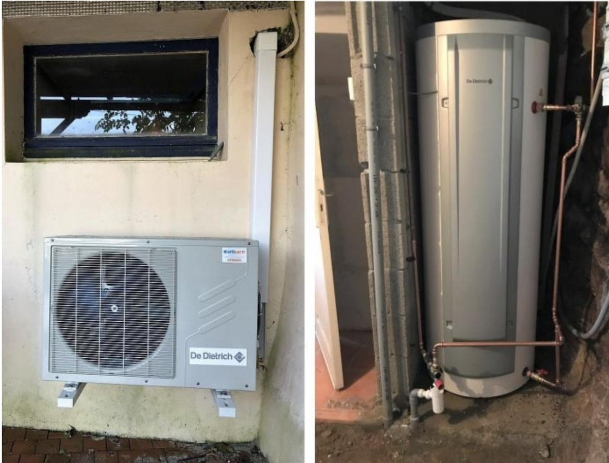
*Installation d'un chauffe eau thermodynamique de dietrich d'une contenance de 270 litre en remplacement d'un ballon électrique. Avec ce système vous pouvez diminuer votre facture jusque par 3 sur l'année.*
