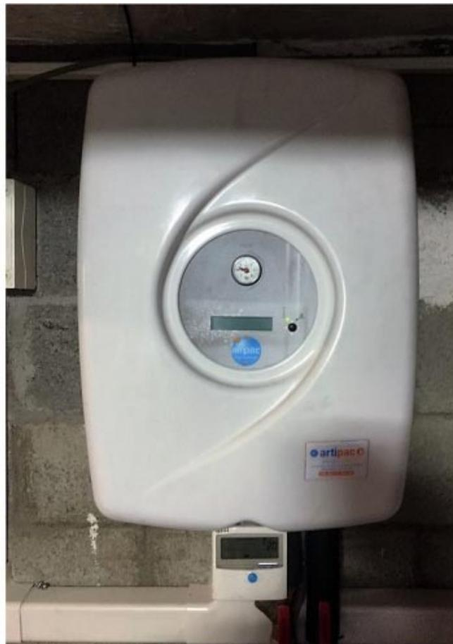
*Installation d'une Pompe à Chaleur Airpac en moyenne température sur radiateur en relève de chaudière. Le groupe extérieur est de marque Sanyo. L'eau chaude sanitaire est assurée par la relève de chaudière fuel. L'ensemble de l'installation est prévue pour une famille de 4 personnes et une maison de 130 m<sup>2</sup>*
