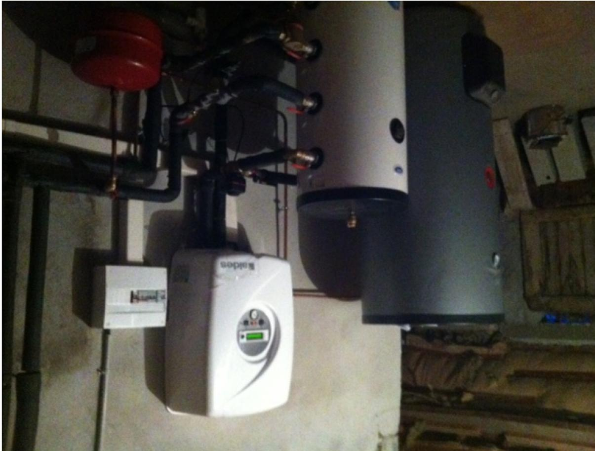
*Installation d'une Pompe à chaleur moyenne température de marque Airpac avec production eau chaude sanitaire en remplacement d'une chaudière fuel. Le groupe extérieur est de marque SAMSUNG*
