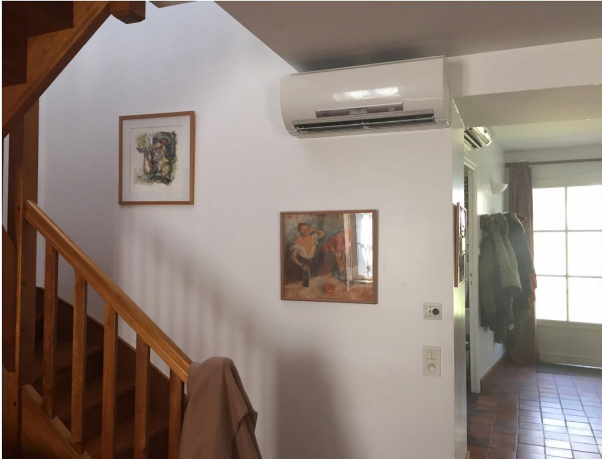
*Installation d'une Pompe à chaleur Mitsubishi Electric Air/Air réversible en remplacement de radiateur électrique. Permet de faire du chaud et du froid a moindre coût.*
