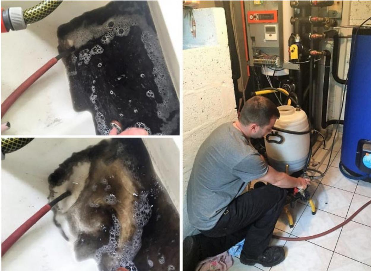
*Ici nous réalisons le désembouage de radiateur. Le désembouage de radiateur apporte une augmentation du rendement et baisse de votre facture.*
