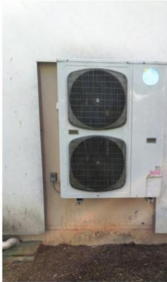
*Installation d'une Pompe à Chaleur air eau de marque Airpac en relève de chaudière. L'installation a été faite sur un réseau existant de radiateur. L'eau chaude est assurée par un ballon électrique. Le groupe extérieur est de marque Sanyo*
