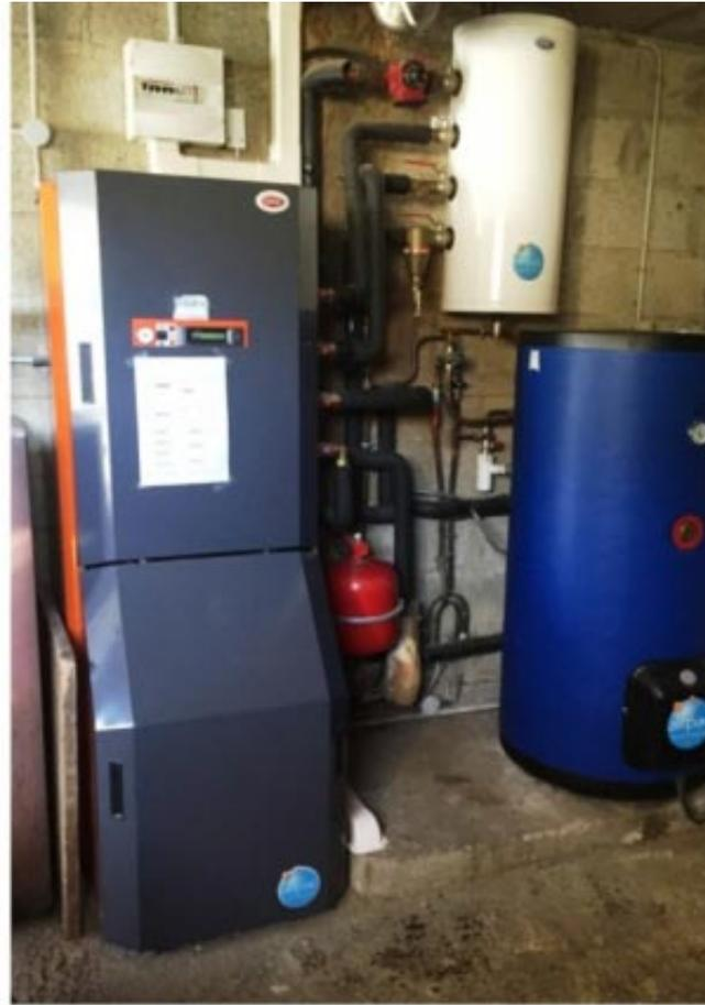
*installation d'une Pompe à Chaleur haute température de marque Airpac en bi étage avec eau chaude sanitaire. température sortie d'eau jusqu'a 70°C. Le groupe extérieur est de marque Sanyo*
